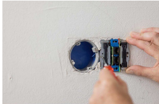
Vastzetten met de montageschroeven behorend bij de toegepaste inbouwdoos
