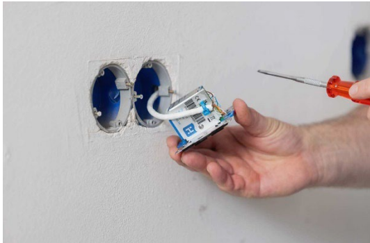
Montage van de APAC W in wand
